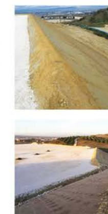
Ndërtimi i Shesheve të Puseve dhe Kontrolli i Erozionit të Argjinaturave , Lease 032B
